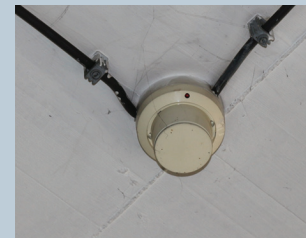
Detektor tymi B me burim radioaktiv
