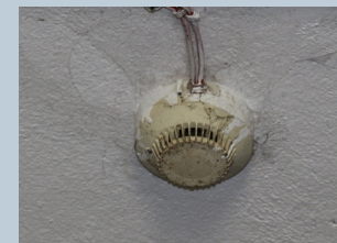
Detektor tymi A me burim radioaktiv
