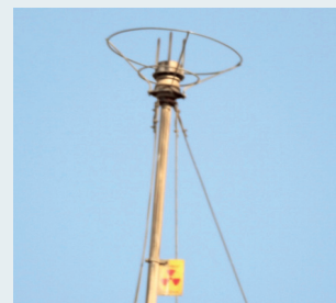
Rrufepritës radioaktiv Tip B
